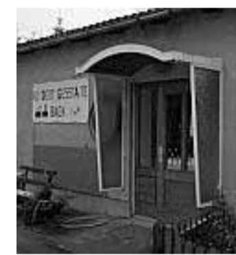
Die Fassade der Kita in Baek soll isoliert werden. FOTOS (2): KNOPF
