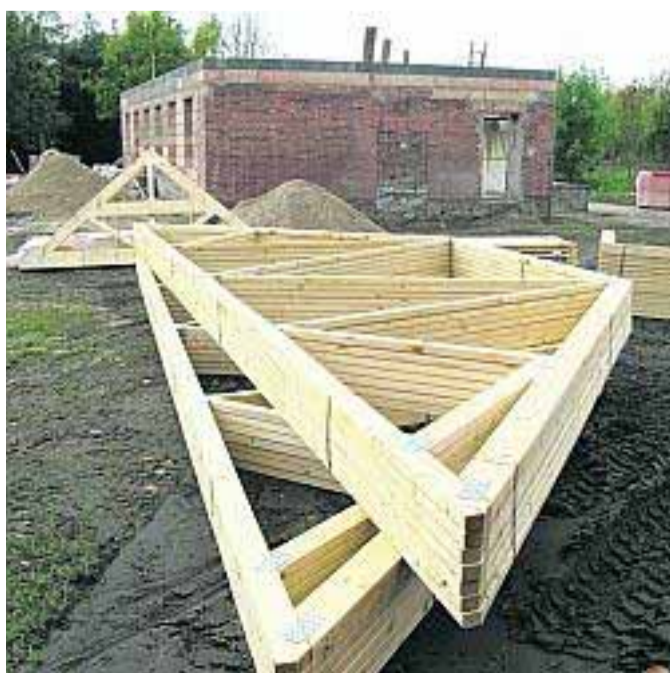
Den Bauauftrag erhielt die Pirower Firma Hofschneider. FOTO: ANKE
